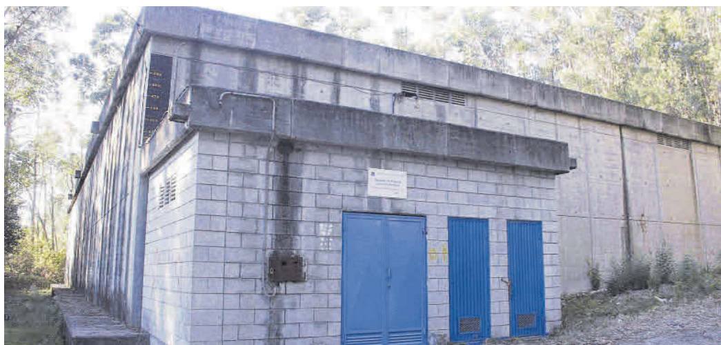
Depósito de aguas en Coiro, con una capacidad de almacenaje de 10.000 metros cúbicos. | Santos Álvarez
